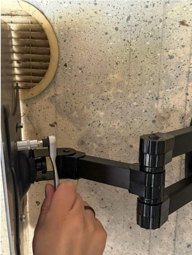
Führen Sie nun den Edelstahlspiegel durch die dafür vorgesehenen Löcher in der Wandhalterung. Platzieren Sie zuerst die Unterlegscheiben und ziehen Sie anschließend die Muttern fest.
